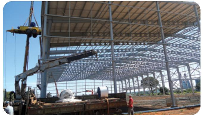
As telhas LRZIP são produzidas no local com até 70 m de comprimento e inclinação mínima de 2,5%. Podem ser utilizadas como telha superior de sistemas sanduíche ou receber isolamento térmico através de lãs minerais revestidas com laminado branco.
