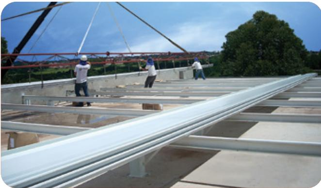
Outra possibilidade de fabricação é içar a perfiladeira até o nível do telhado para produzir as telhas.
