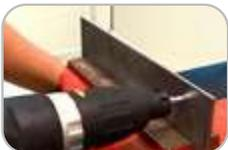
Antes de realizar a aplicação no local desejado, é recomendado que faça o teste de regulagem em um pedaço de chapa da mesma espessura das terças para ajustar o limitador de profundidade de fixação da parafusadeira, para não forçar demais as arruelas de vedação dos fixadores autooperfurantes e nem deixar com folga, assim comprometendo a vedação e fixação.
