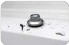
Após a aplicação é importante a limpeza do local, pois durante a aplicação são liberadas fagulhas/limalhas no local e se não retiradas podem causar corrosão na cobertura.
