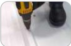
Após a regulagem, pode-se iniciar a aplicação no local desejado, lembrando que para cada tipo de superfície é utilizado um tipo de fixador autooperfurante.
