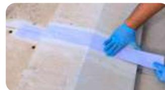
Sobreposição de chapas com Flexfelt Autoadesiva
